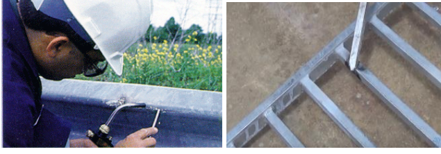
Şekil 3: Çinko-esaslı çubuk veya lehimler ile SDG Galvaniz tamiri
